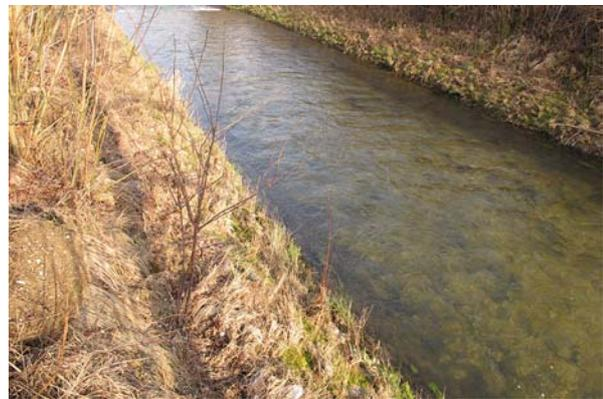
**Bild 58** Km 13.62-13.32, links: Das Ufer ist oberhalb des Uferschutzes erodiert (schlechter Zustand). Rechts ist es in einem guten Zustand.
