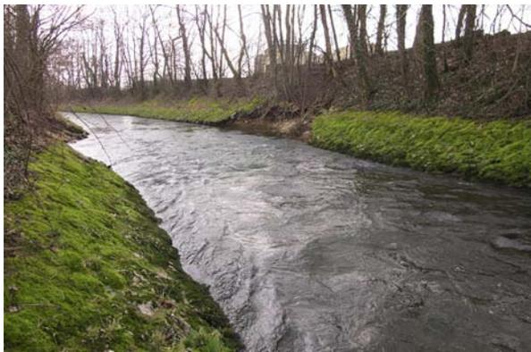
**Bild 17** Km 18.1-18.0, beidseits: Der Uferschutz ist lokal beidseits auf einer Länge von 6m zerstört.
