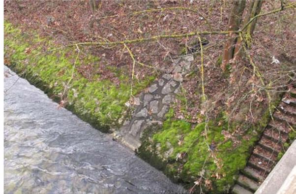
**Bild 26** Km 17.4, rechts: Reparierter Uferschutz.
