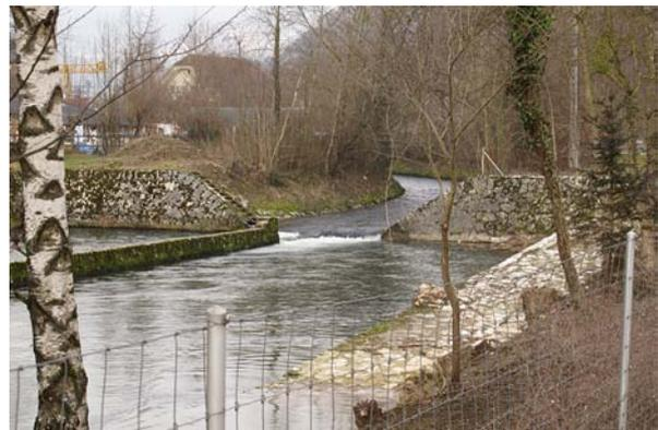
**Bild 12** Km 18.34-18.3, Geschiebesammler: Die Schwelle beim Einlauf ist rechts leicht beschädigt.
