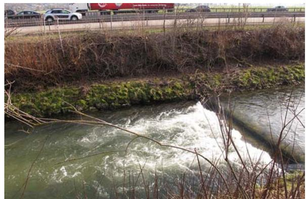
**Bild 54** Km 15.2, rechts: Das Ufer ist oberhalb des Uferschutzes erodiert.
