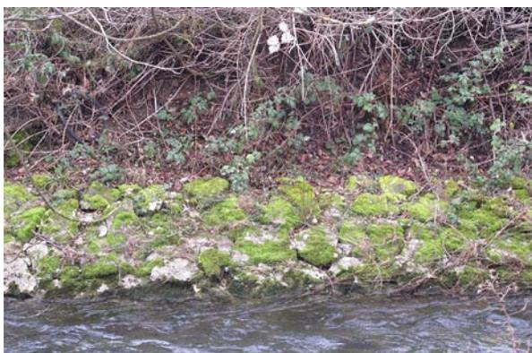
*Bild 23* Km 17.8-17.52, rechts: Der Verbund weist Löcher auf und bildet eine Schwachstelle im Uferschutz.
