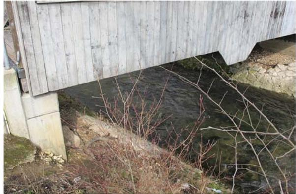
**Bild 28** Km 17.3, beidseits: Der Uferschutz ist unter der bedachten Brücke beschädigt. Blick flussaufwärts.
