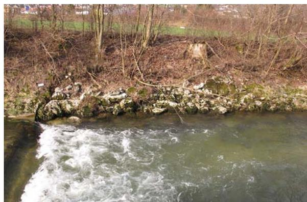
**Bild 48** Km 15.82, links: Das Ufer ist zerstört. Das Querholz der Schwelle ist von unten hinterspült.
