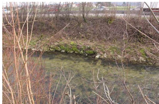
**Bild 60** Km 13.13, rechts: Der Uferschutz ist bei der Schwelle auf einer Länge von ca. 6m in einem schlechten Zustand. Links ist er auf einer Länge von 20m in einem schlechten Zustand.
