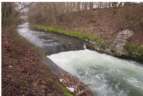
**Bild 34** Km 17.08: Der Absturz ist aus fischerlicher Sicht sanierungsbedürftig. Er ist in einem guten baulichen Zustand. Am linken Ufer ist die nachgebesserte Stelle leicht beschädigt. Blick flussaufwärts.
