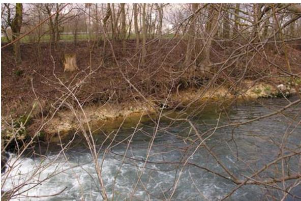
**Bild 41** Km 16.43, links: Der Uferschutz ist nach der Schwelle auf einer Länge von ca. 10m zerstört. Die Rückgriffweite beträgt 1-2m.
