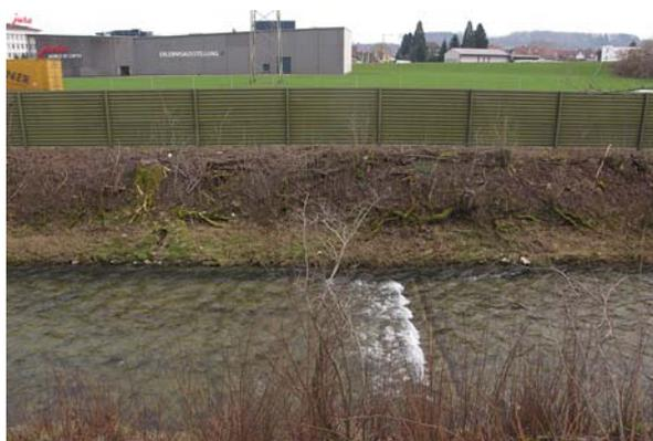
**Bild 66** Km 12.5-12.35: Das rechte Ufer ist oberhalb des Schutzes teilweise erodiert (mittlerer Zustand).
