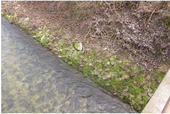
**Bild 43** Km 16.3, rechts: Der Uferschutz ist geschwächt. Blick von der Feldbrücke flussabwärts.
