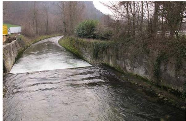
**Bild 10** Km 18.5, beidseits: Die Ufermauern und der aus fischereilicher Sicht sanierungsbedürftige Absturz sind in gutem Zustand.
