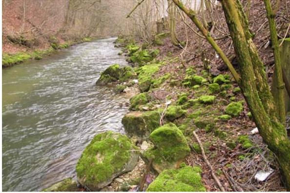
**Bild 7** Km 18.6, links: Ein Blockwurf in gutem Zustand schützt die Ufer. Blick flussaufwärts.
