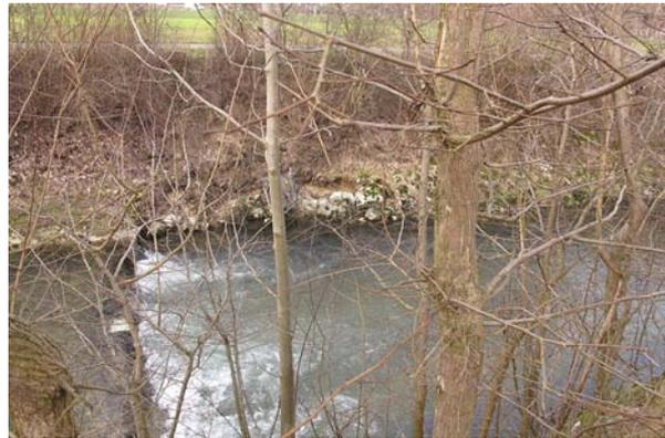
**Bild 46** Km 16.18, links: Der Uferschutz ist nach der Schwelle auf einer Länge von ca. 6m zerstört. Die Rückgriffweite beträgt 1-2m.
