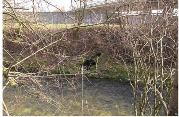
**Bild 50** Km 15.62, rechts: Der Uferschutz ist bei der Einleitung einer Entwässerung lokal zerstört. Der Allgemeinzustand des rechten Ufers im Abschnitt ist schlecht.
