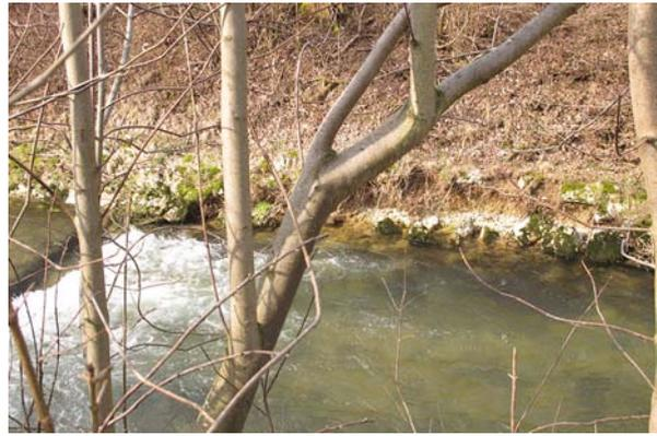
**Bild 44** Km 16.28, links: Der Uferschutz ist nach der Schwelle auf einer Länge von ca. 6m zerstört. Die Rückgriffweite beträgt 1-2m.
