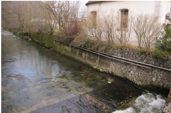
**Bild 9** Km 18.5, rechts: Die Ufermauer ist in einem schlechten Zustand. Blick flussaufwärts.
