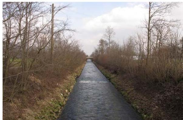
**Bild 42** Km 16.42-16.06, beidseits: Bei zwei Schwellen ist das Ufer erodiert. Ansonsten ist das Ufer in mittlerem Zustand (einzelne Beschädigungen).
