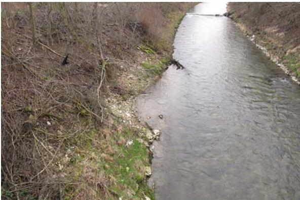
*Bild 69* Km 11.8, rechts: Der Uferschutz ist auf einer Länge von ca. 6m zerstört. Die Rückgriffweite beträgt 1-2m. Blick flussaufwärts.
