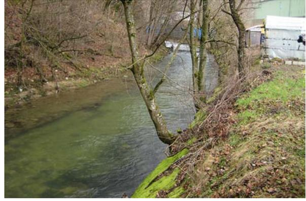
**Bild 8** Km 19.05-18.57: Die Sohle ist in der Gerinnemitte erodiert. An den Ufern ist die nicht erodierte, kolmatische Schicht erkennbar. Blick flussaufwärts.
