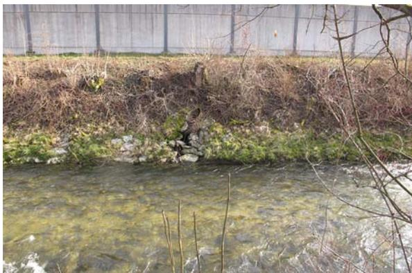
**Bild 53** Km 15.26, rechts: Der Uferschutz ist bei der Einleitung einer Entwässerung lokal zerstört.
