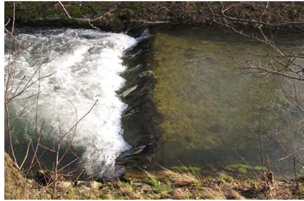
**Bild 56** Km 14.38: Das Querholz der Schwelle ist von unten hinterspült. Die Ufer sind beidseits geschwächt.
