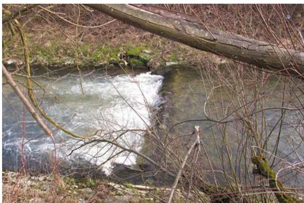
**Bild 59** Km 13.18: Das Querholz der Schwelle ist unterspült. Der rechte Uferschutz ist lokal in schlechtem Zustand. Dasselbe gilt für die Schwelle bei km 13.33.
