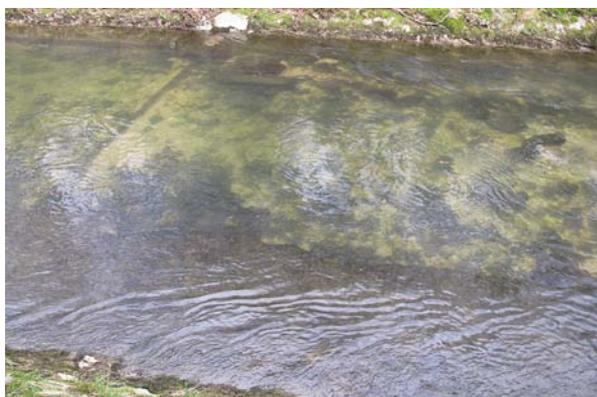
**Bild 33** Km 17.12: Die Sohle ist in der Gerinnemitte erodiert. Es ist ein Querholz und auf der rechten Seite das Längsholz der Foundation erkennbar. Der Uferschutz ist in mittlerem Zustand.
