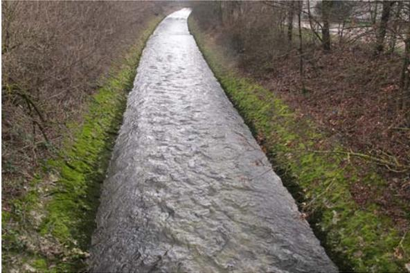
**Bild 25** Km 17.52 bis 17.37, beidseits: Der Uferschutz aus Blocksatz ist in einem guten baulichen Zustand.
