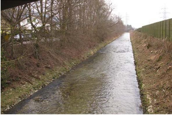
*Bild 67* Km 12.35-11.78, beidseits: Die Ufer sind oberhalb des Schutzes teilweise leicht erodiert und weisen einzelne Beschädigungen auf (mittlerer Zustand).
