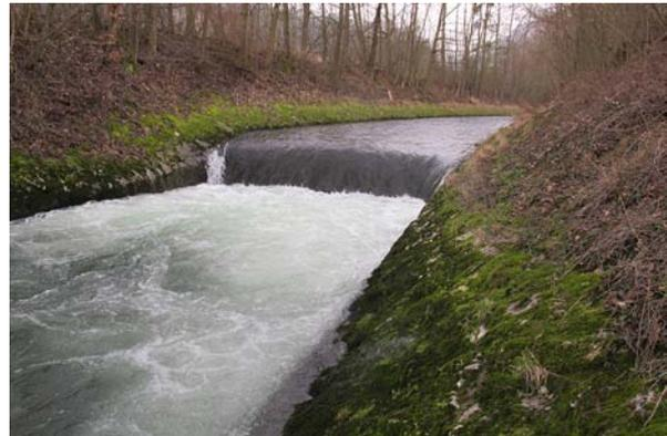
**Bild 16** Km 18.06: Der Absturz ist aus fischereilicher Sicht sanierungsbedürftig. Er ist in einem guten baulichen Zustand. Blick flussaufwärts.
