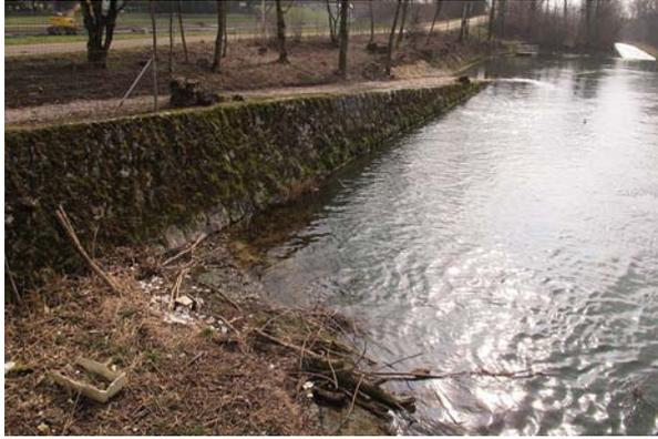
**Bild 13** Km 18.34-18.3, links: Die Ufer des Geschiebesammlers bestehen aus Blocksatz in gutem Zustand.
