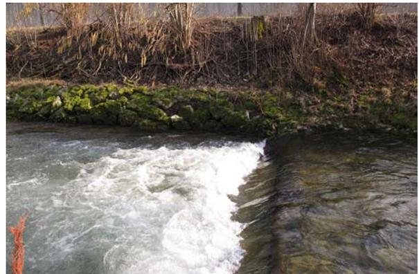
**Bild 52** Km 15.48, rechts: Der Uferschutz ist bei der Schwelle auf einer Länge von ca. 6m in einem mittleren Zustand. Das Querholz der Schwelle ist von unten hinterspült.
