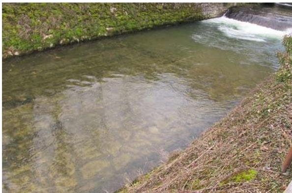
**Bild 11** Km 18.5, Sohle: Die Sohle unterhalb der Schwelle ist gepflästert. Blick flussaufwärts.
