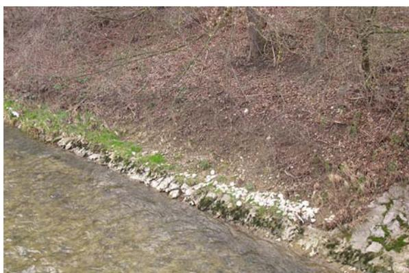
**Bild 65** Km 12.5-12.35: Das linke Ufer ist oberhalb des Schutzes teilweise mit einer Rückgriffweite bis zu 2m erodiert (schlechter Zustand).
