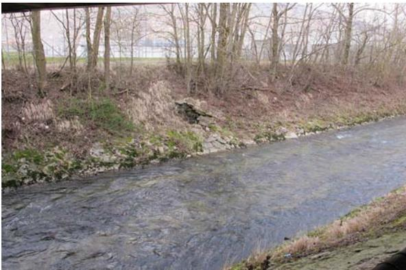
**Bild 39** Km 16.53, links: Der Uferschutz ist lokal zerstört.
