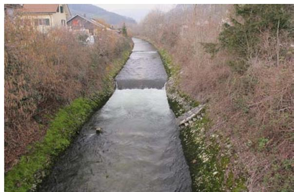
*Bild 24* Km 17.52: Der Absturz ist aus fische-reilicher Sicht sanierungsbedürftig. Er ist in einem guten baulichen Zustand. Blick flussaufwärts.
