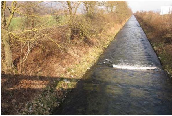
**Bild 55** Km 14.6-14.38, beidseits: Die Ufer sind oberhalb des Schutzes teilweise erodiert (mittlerer Zustand).
