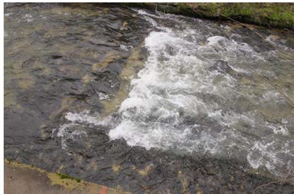
**Bild 4** Km 19.05: Die Sohle nach der Schwelle ist in der Gerinnemitte erodiert.
