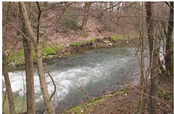
**Bild 30** Km 17.15, beidseits: Der Uferschutz ist beidseits auf einer Länge von ca. 20m zerstört. Die Rückgriffweite beträgt 1-2m.
