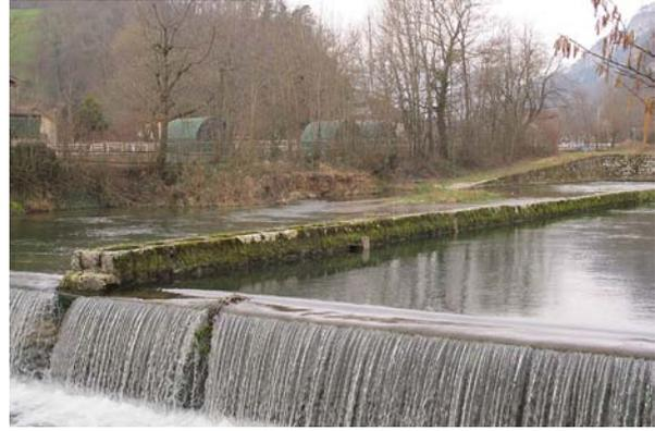
**Bild 14** Km 18.34-18.3, rechts: Der Blocksatz am Ufer ist im unteren Teil bewachsen. Eine Anlandung beansprucht einen Teil des Ufers. Blick vom Auslaufbauwerk flussaufwärts.
