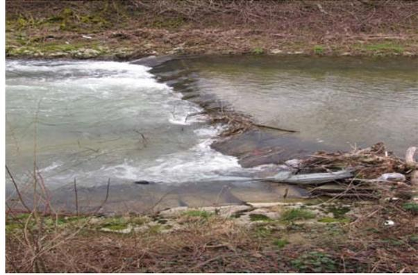
*Bild 68* Km 11.96, links: Der Uferschutz ist bei der Schwelle lokal zerstört.
