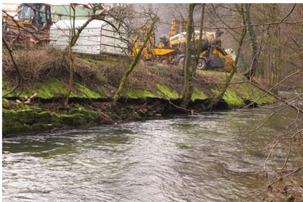
**Bild 5** Km 19.04, links: Der Uferschutz auf der Innenseite (Industrie) besteht aus Blocksatz und Betonplatten. Er ist zerstört.
