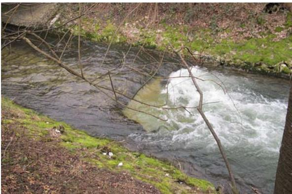
**Bild 29** Km 17.15: Die Sohle bei der Schwelle ist in der Gerinnemitte erodiert.
