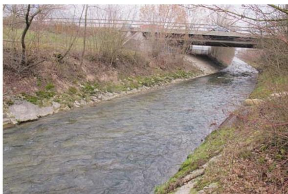
**Bild 36** Km 16.6-16.5, beidseits: Im Uferschutz sind mehrere kleine beschädigte Stellen vorhanden (mittlerer Zustand).
