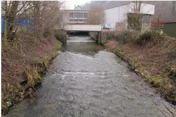
**Bild 1** Km 19.13-19.09, beidseits: Blocksatz in mittlerem Zustand, der teilweise unterspült ist. Blick flussaufwärts.
