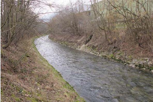
**Bild 37** Km 16.65, links: Der Uferschutz ist bei der Einleitung einer Entwässerung lokal zerstört. Blick flussaufwärts.
