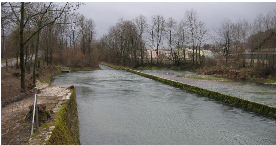
Bild 8 Geschiebesammler ausgangs Klus bei Oensingen. Blick in Flussrichtung.
