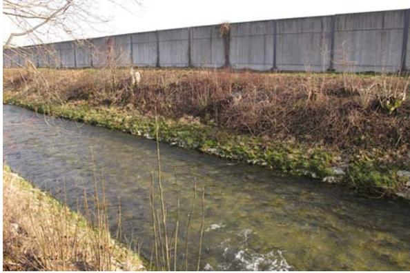
**Bild 49** Km 15.68-14.6: Der Uferschutz ist links in einem mittleren Zustand, rechts in einem schlechten Zustand.
