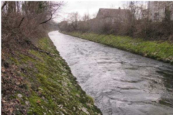
*Bild 21* Km 17.8-17.52, beidseits: Der Ufer-schutz aus Blocksatz hat einzelne be-schädigte Stellen (mittlerer Zustand).
