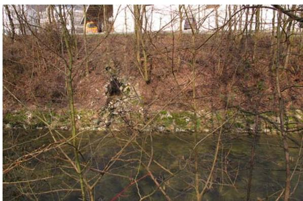
**Bild 35** Km 16.775, links: Der Uferschutz ist bei der Einleitung einer Entwässerung lokal zerstört. Blick flussaufwärts.
