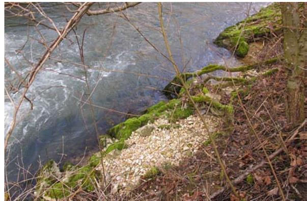
**Bild 40** Km 16.43, rechts: Der Uferschutz ist nach der Schwelle auf einer Länge von ca. 10m zerstört. Die Rückgriffweite beträgt 1-2m.
