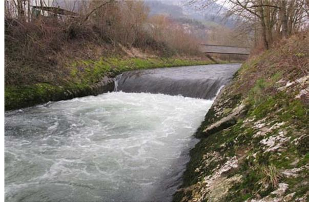
*Bild 20* Km 17.84: Der Absturz ist aus fische-reilicher Sicht sanierungsbedürftig. Er ist in einem guten baulichen Zustand. Blick flussaufwärts.
