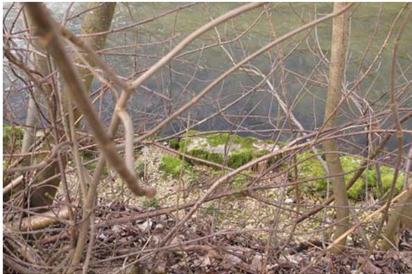
**Bild 45** Km 16.28, rechts: Der Uferschutz ist nach der Schwelle auf einer Länge von ca. 6m zerstört. Die Rückgriffweite beträgt 1-2m.
