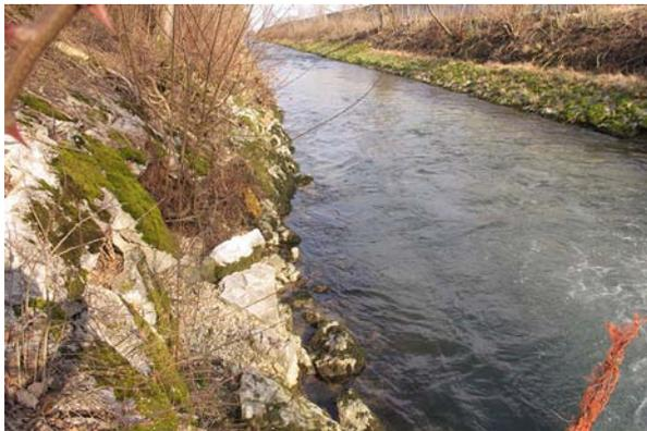
**Bild 51** Km 15.48, links: Der Uferschutz ist bei der Schwelle auf einer Länge von ca. 6m in einem schlechten Zustand. Die Rückgriffweite beträgt 2m.
