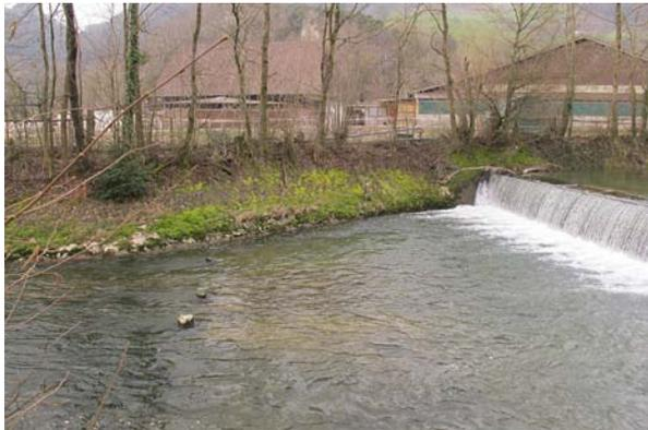
**Bild 15** Km 18.23, Geschiebesammler: Der aus fischereilicher Sicht sanierungsbedürftige Absturz beim Auslauf und das Tosbecken sind in einem guten Zustand. Blick flussaufwärts.
