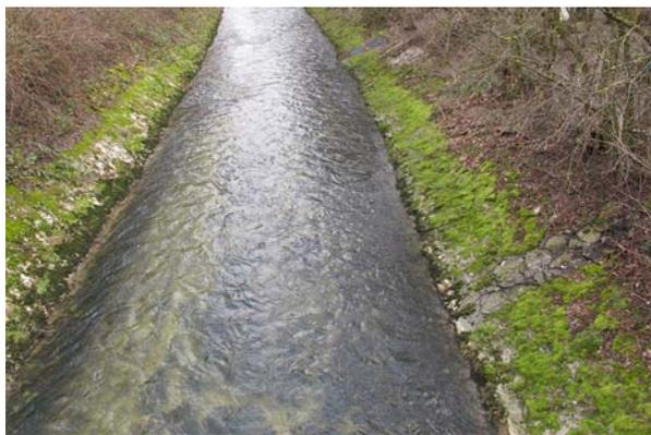
**Bild 31** Km 17.12-16.77, beidseits: Im Uferschutz sind mehrere kleine beschädigte Stellen und Nachbesserungen vorhanden (mittlerer Zustand).
