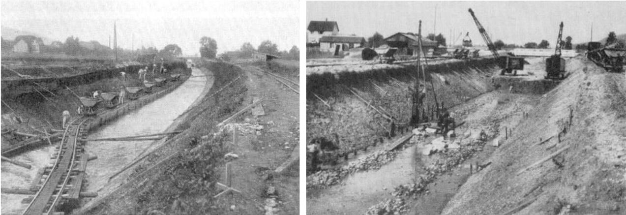
Abbildung 5: Bau des neuen Kanals in Handarbeit zwischen Rickenbach und Wangen (links) und mit Baggen bei Egerkingen (rechts).
