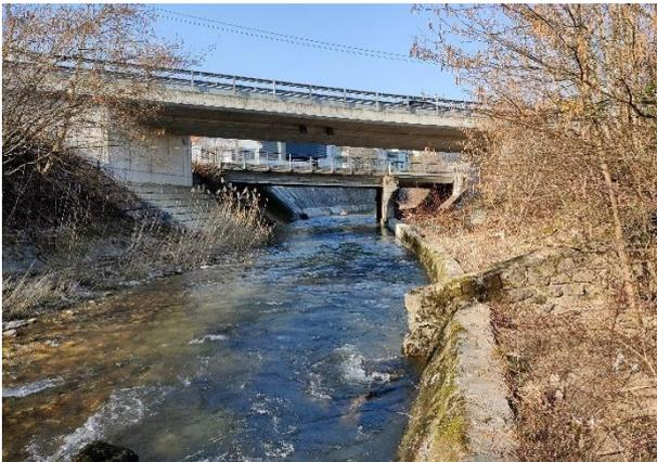
Abbildung 22: Kanalisiertes, verbautes Gerinne km 1.35 Olten.
