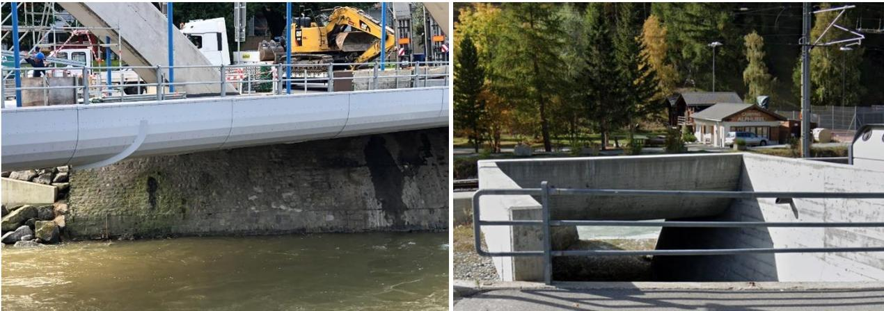
Abbildung 76: Beispiele von Brücken mit Staukragen und Verschalung der Untersicht (links: Brücke in Emmenbrücke/Luzern über der kleinen Emme; rechts: Brücke in Täsch über den Täschbach vor der Mündung in die Vispa).
