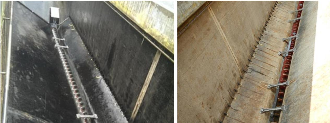
Abbildung 102: Beispiel einer Förderschnecke im Sandfang der ARA Sensetal ([www.sensetal.ch](http://www.sensetal.ch)). Durch die Rotation der Förderschnecke werden Feststoffe aus dem Sandfang transportiert. Wenn die Förderschnecke in einem geschlossenen Rohr verläuft, können Feststoffe auch aufwärts transportiert werden.
