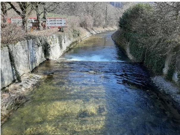
Abbildung 18: Uferverbau und Schwelle km 18.575, Oensingen Brücke Klusstrasse.
