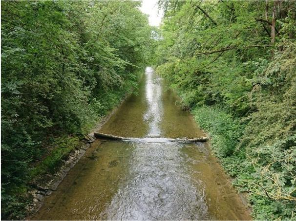
Abbildung 20: Kanalisiertes Gerinne mit Schwelle km 9.38 Egerkingen.
