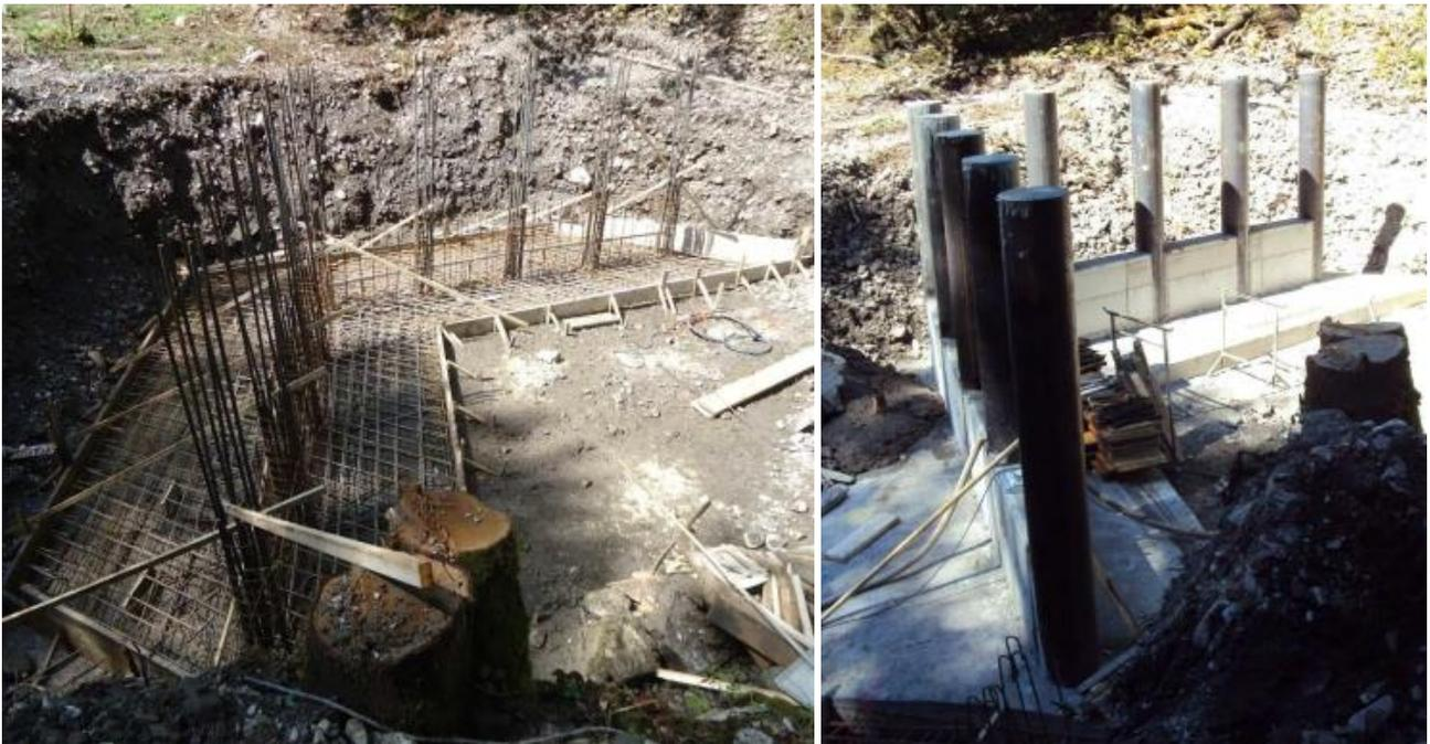
Abbildung 56: Beispiel für den Bau eines V-förmigen Schwemmholzrechens am Reidenbach in Boltigen (Emch+Berger AG Bern).
