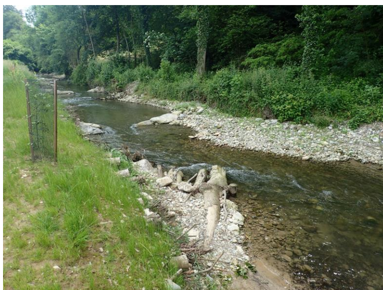
Abb. 7: Beispiel für Massnahmen zur Gerinnestrukturierung – Surb in Döttingen AG
