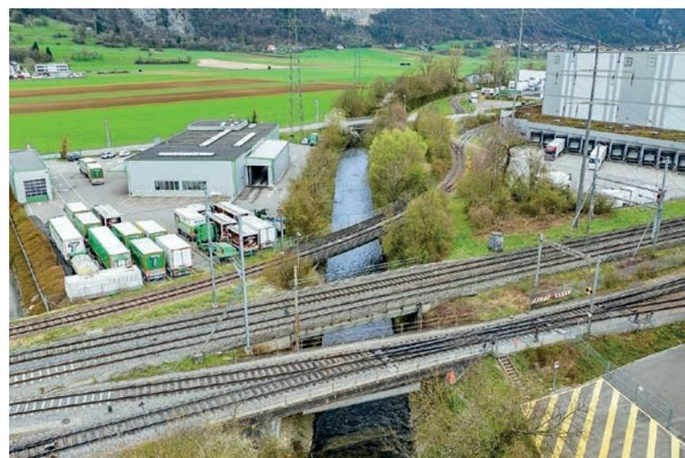
Das Projekt sieht eine umfassende Kapazitätserweiterung der Dünnern über den gesamten Streckenabschnitt vor. Das Gerinne wird auf eine Wassermenge von 140 m<sup>3</sup>/s (Höhe Oensingen) bis 160 m<sup>3</sup>/s (Höhe Olten) ausgebaut. Darin berücksichtigt ist ein Freibord von ca. 80 cm als Reserve für Treibgut, Wellenbildung und Geschiebeumlagerungen. Damit wird das angestrebte Schutzziel HQ<sub>100</sub> vollumfänglich erreicht.
